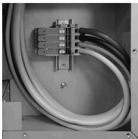
Fig. 24 : Bornes présentes dans le boîtier de raccordement
